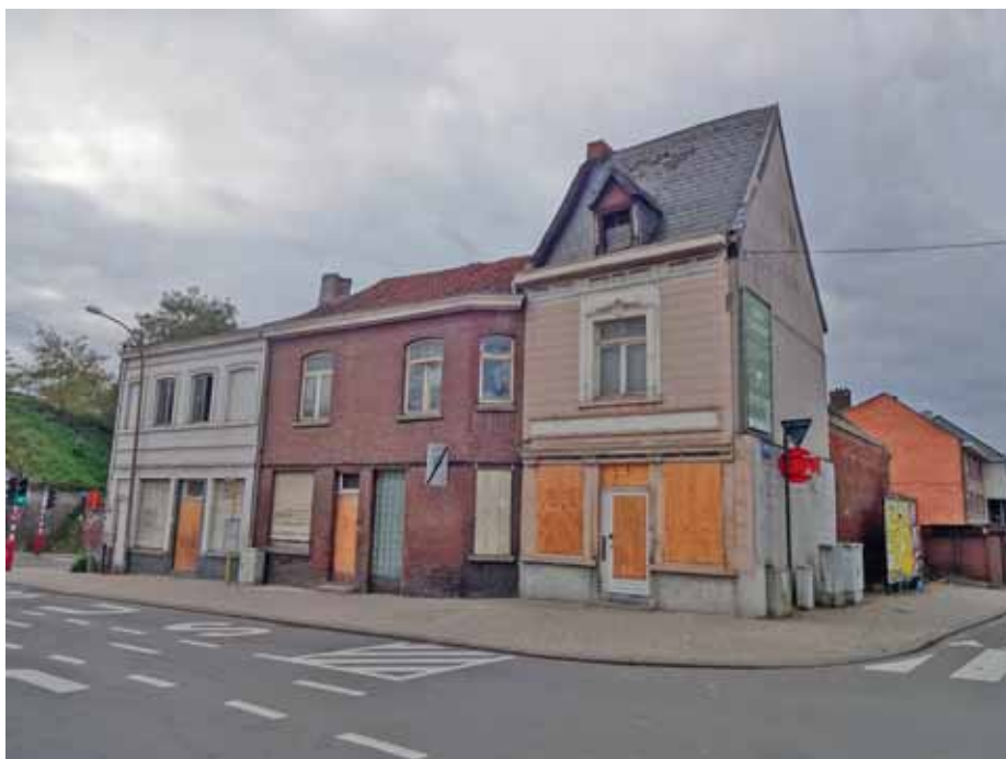
Voor cohousingproject De Sijs worden op het toekomstige bouwterrein twee woningen afgebroken. Het gebouw rechts blijft bewaard en wordt geïntegreerd in het wooncomplex, waar het zal fungeren als gemeenschappelijke ruimte.
